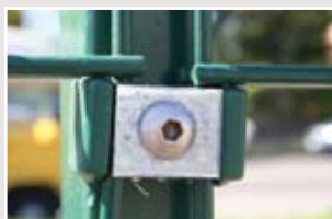
Gjerdestolper for låsing av gitter med kleplate og umbrakobolt
