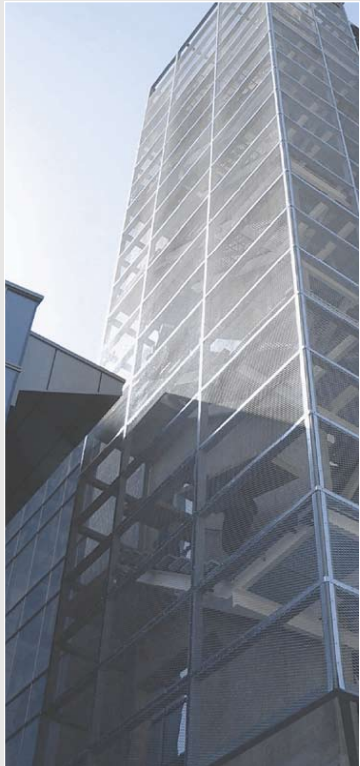
Strekkm metall i trappehus
